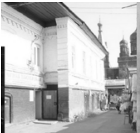
10. Здание бывшей земской уездной больницы, где в 1886 – 1909 г. работал врач М.И. Мизеров, ул. Свободы, 16. Как первая очередь зданий комплекса построено в 1886 году. Здесь работал земский врач, общественный деятель и почетный гражданин города М.И. Мизеров.
