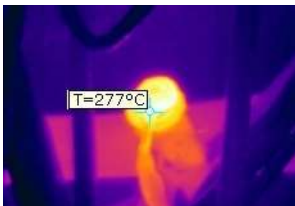
Рисунок 22. Пример обнаружения пожароопасного разогрева болтового контактного соединения
